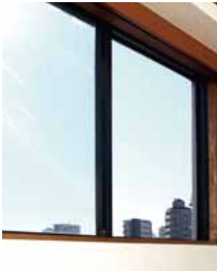
【方立補助枠設置前】
