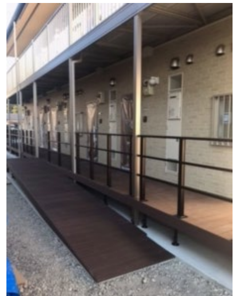
栃木県 老人ホーム ルポウッドチャコールブラウン/ (鋼製根太・プラ束) / デッキフェンス2本格子
