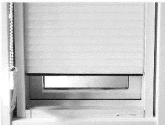
4. ボトムバー（室外側）を手で持ち上げ、ボトムバーの隙間に横インナーレールの端を強く押し込みます。
