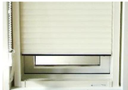
6. ボトムバー（室外側）を手で持ち上げ、ボトムバーの隙間に横インナーレールの端を強く押し込みます。横インナーレールの端がはまったらそのまま、もう片方の端に向けて押し込んで入れてください。
