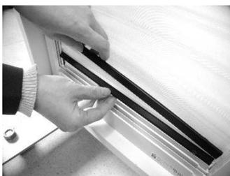
6. 本体カバーの下側を持ち上げ、90° 開いてから本体ボックス側に押し込んで固定して下さい。
